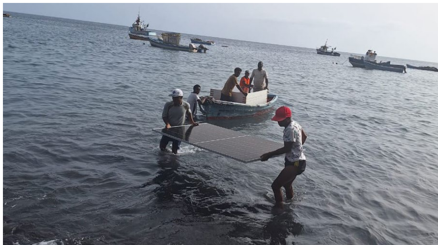
Descarga dos módulos em Monte Trigo.
